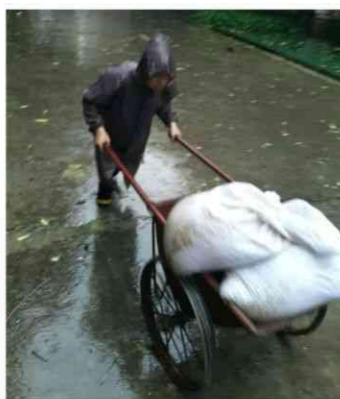
在南国雅苑项目，为防止积水进入大堂损坏电梯，造成业主出行不便，冒雨搬运沙包做防水墙。
