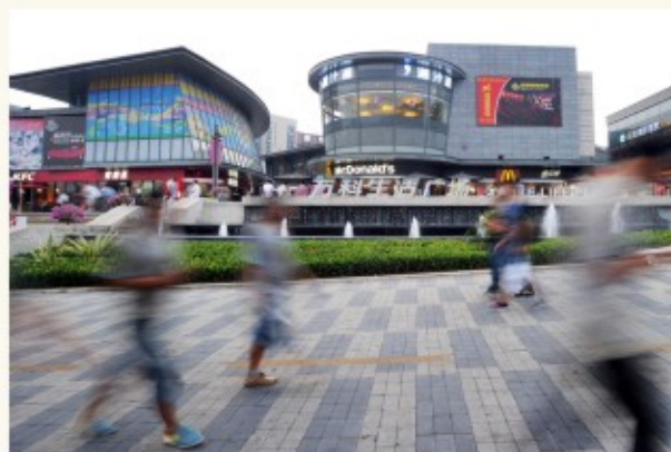
★ 名称：松湖生活广场 项目属性：商业/建成年份：2014年全部建成投入使用
