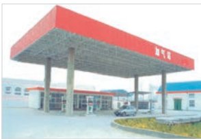
中油同舟公司——清洁能源交通工具的天然加气站项目。
