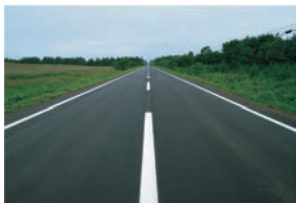
筑波路桥道路养护——广东筑波路桥工程有限公司—道路养护专业的先锋。
